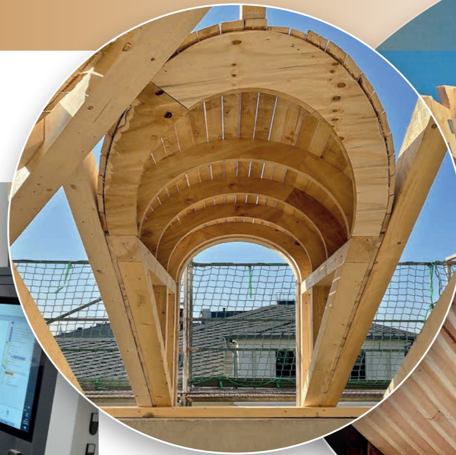
Gaubenkonstruktion: Beim Dachstuhl des Bauprojekts Königshöfe Dresden wurden 70 Gauben benötigt.
